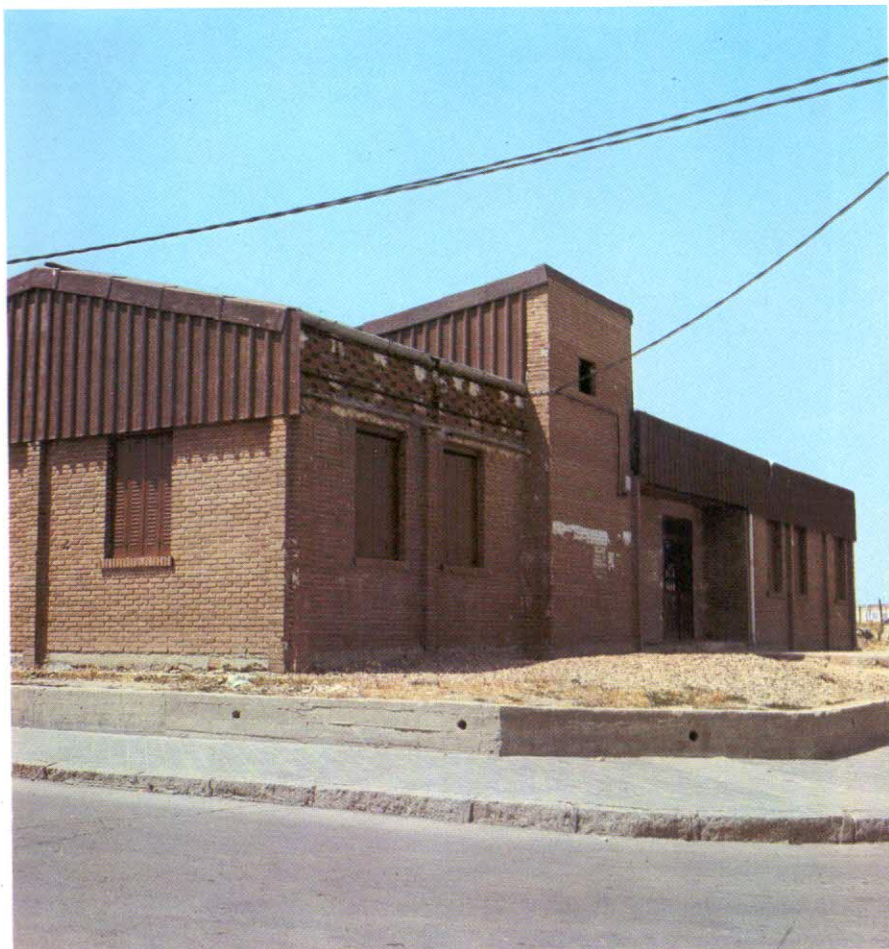
El local de la Asociación de Vecinos de Orcasur, terminándose de construir. Circunstancias particulares han permitido que la calidad de la construcción y el cuidado de los detalles sean superiores a otros casos similares. No es extraña, al resultado, la dedicación vocacional del arquitecto de la Asociación.
