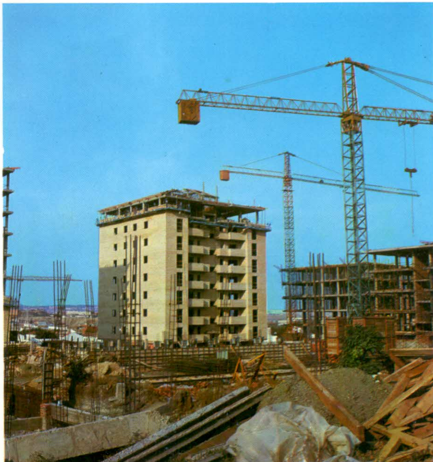
Aspecto de las torres en construcción.
